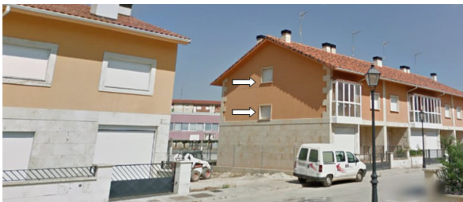
Ventanas de edificación situada en la parcela vecina
